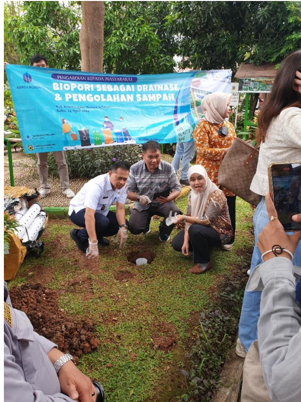
Gambar 10, Praktek Pemasangan Biopori (1)
